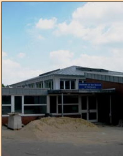
Die Renovierungsmaßnahmen am Süsteresch sind in vollem Gange.
