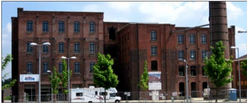
In Zukunft Heimat eines Ärztehauses? Das alte Spinnereigebäude am Vechtezentrum.
