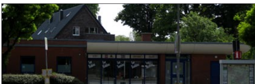
Frühere Planungen sahen ein Ärztehaus am Postgebäude vor. Hier entstand nun ein Mehrfamilienhaus.
